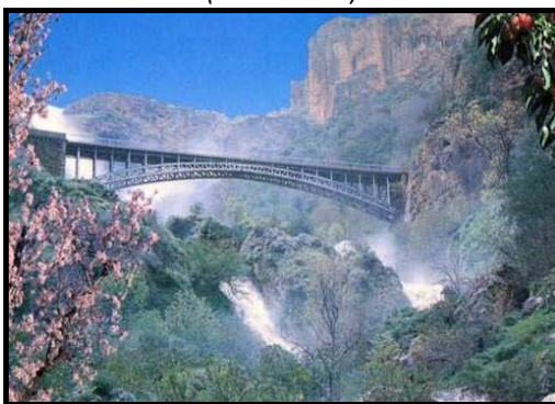
Pont ferroviaire et cascades d'El-Ourit
